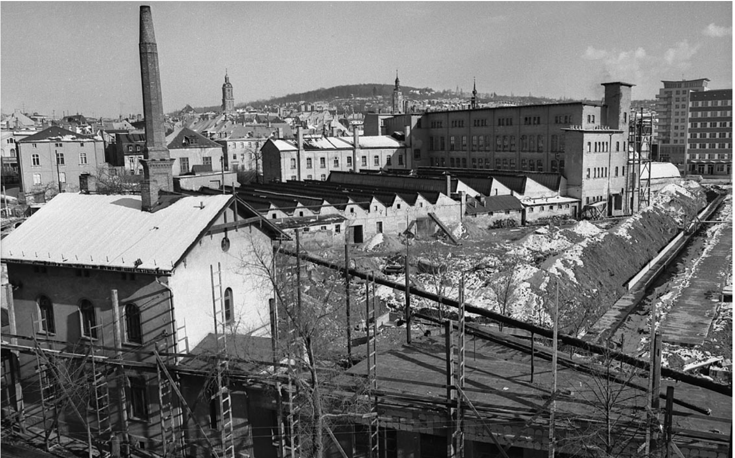
Abbruch und Neuaufbau im Zentrum von Gera, gesehen aus dem Haus der „Volkswacht“. Es wird Platz geschaffen für die neuen Wohnblöcke. Begonnen ist bereits der unterirdische Kanal für die Versorgungsmedien (rechts am Bildrand).
